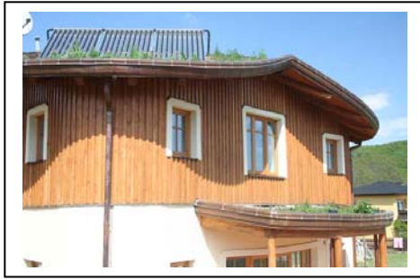
Obr. 7 Fasáda domu z měsíce května. Z velikosti stínu je vidět jak přesahy střech stíní jižní a západní okna. Interiéry domu se tak nepřehřívají. Dřevěná fasáda a střecha jsou provětrávané. Kolektory jsou pro ohřev TUV.
