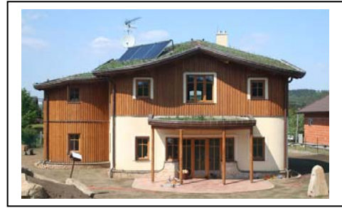
Obr. 8 Jižní fasáda rodinného domu. Obvodová zeď je z tepelněizolačních cihel tl. 24cm izolovaná minerální vlnou v tloušťce 20cm, krov 24cm a podlaha přízemí 14cm. Celkové tepelné ztráty domu 8,6 kW. Zdroj tepla – plynový kotel 11 kW
