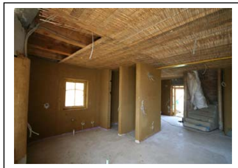
Obr. 10 Rozestavěné přízemí domu. Povrchy vnějších zdí jsou na stěnové teplovodní topení omítnuty hliněnými omítkami. Strop je celodřevěný s podbitím prkny, rákosem a hliněnou omítkou. Vnitřní příčky a zvukově izolační vrstva na podlaze 1. patra jsou z nepálených cihel.
