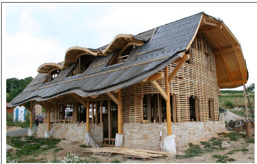
Obr. 3 Dřevostavba rodinného domu z přírodních stavebních materiálů. Dům bude izolován 350mm tlustými balíky z obilné slámy. Na fotografii je vidět vodorovné laťování ke kterému přijdou slaměné balíky zevnitř přirazit a dopěchovat (detail skladby stěny obrázek č. 4). Dům bude mít břidlicovou krytinu a na horním menším sklonu střechy bude bezúdržbová zelená střecha. Pod všemi povrchy střechy je 80mm odvětrávaná vzduchová mezera.
