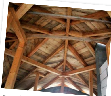
Konstrukce celodřevěného trámového stropu v podkrovní
