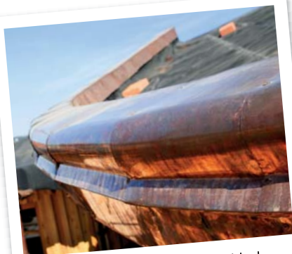
Měděná klempířská obruba drží oblouk pro extenzivní zelenou střechu.
