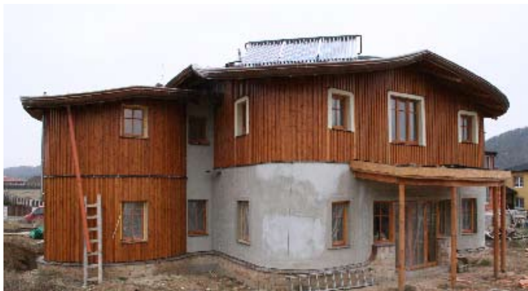
Nízkoenergetický dům před dokončením fasády. Stavba má nosné zdivo z pálených cihel tloušťky 17 cm a zateplení z minerální vlny tloušťky 25 cm. Levá část domu je dřevostavba. Na této části stavby a v 1. patře je odvětrávaná fasáda z modřinových prken. Na střeše bude bezúdržbová zelená střecha. Osazen je vakuový sluneční kolektor pro ohřev teplé užitkové vody
