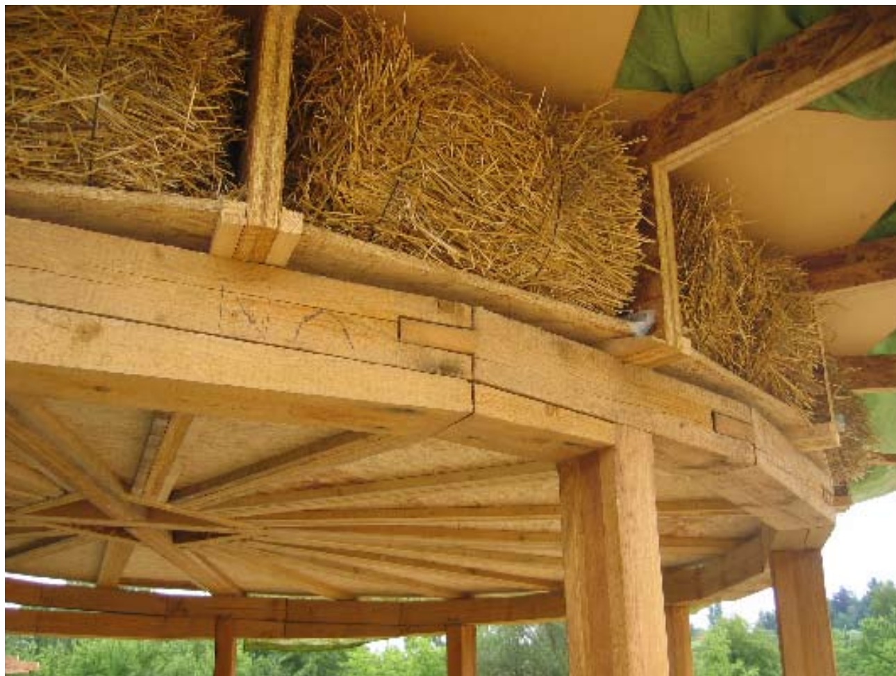
Pro izolaci střeby tvoří běžnou a cenově nejdostupnější variantu slisované balíky z obilné slámy o rozměrech 45 x 35 x 70 cm
