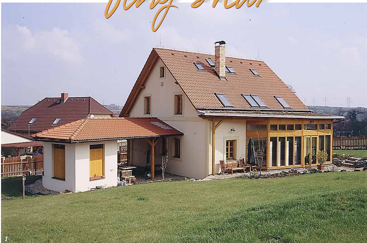
1 Zimní zahrada dodává teplo do domu v přechodných obdobích roku, v zimních měsících je možné ji plně uzavřít od obytných prostor
