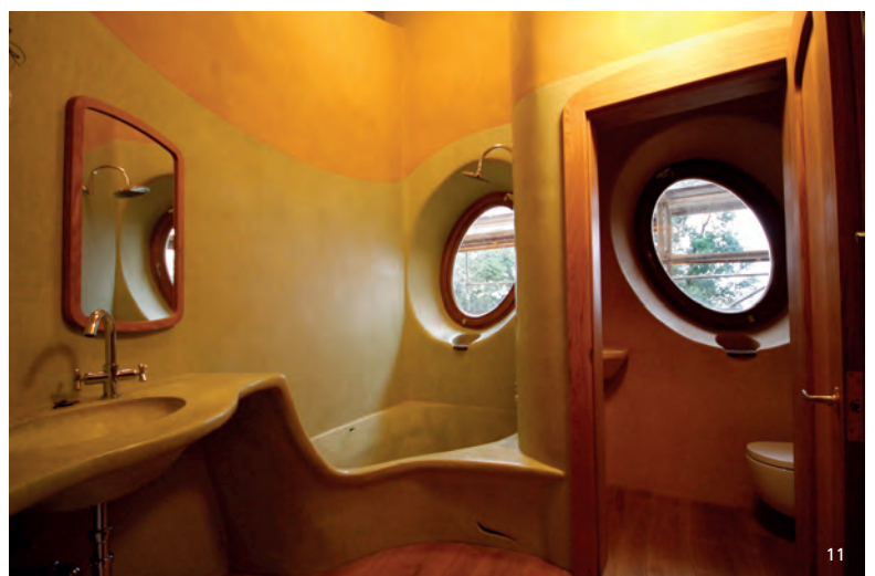
Bild 11 Badezimmer mit wasserfestem marokkanischen Kalkputz (Tadelakt) an den Wänden
