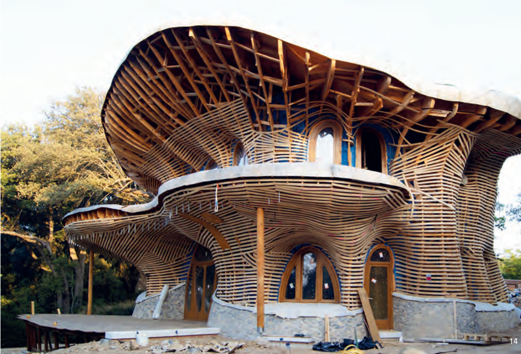
Bild 14 Unterkonstruktion der Fassade
