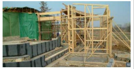
ДОМ НЕ ОБЯЗАТЕЛЬНО ДОЛЖЕН СТОЯТЬ НА БЕТОННОЙ ПЛИТЕ. ФОТО: ЛЕНТОЧНЫЙ ФУНДАМЕНТ ИЗ ПРИРОДНОГО ЦЕЛЬНОГО КАМНЯ, ПОДГОТОВЛЕННЫЙ К УКЛАДКЕ РОСТВЕРКА И БАЛОК ПРОВЕТРИВАЕМОГО (ВЕНТИЛИРУЕМОГО) ПОЛА
