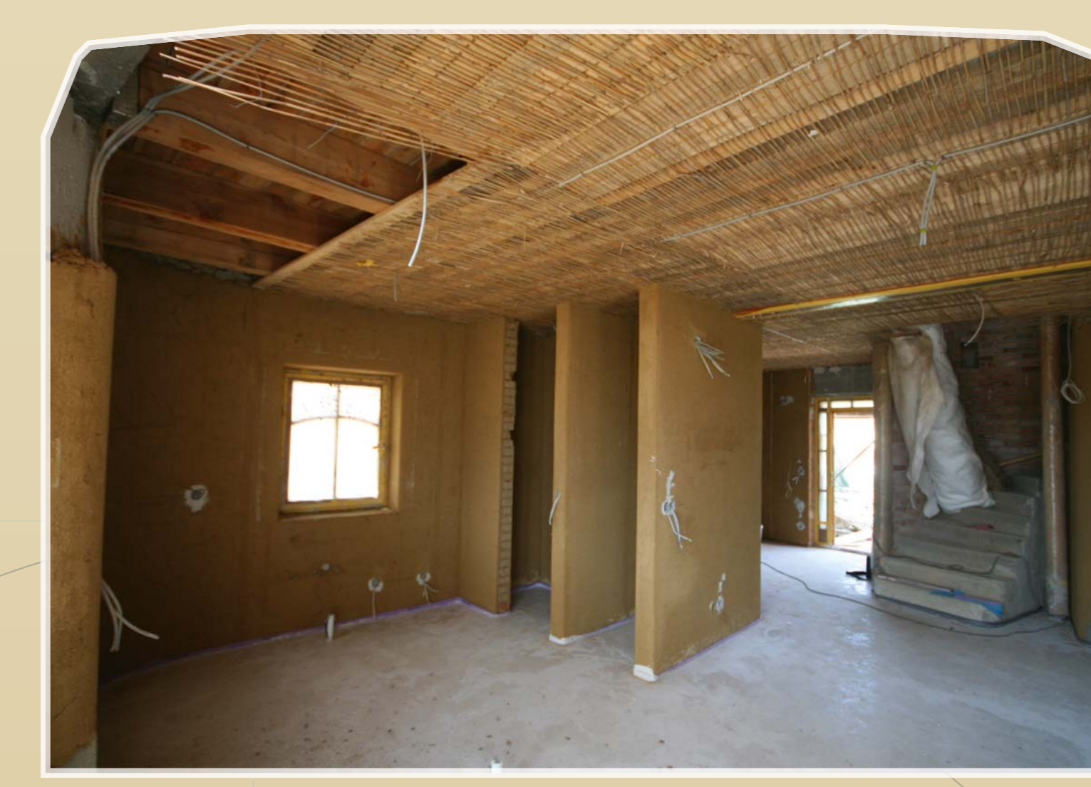
Akumulační stěny z nepalovaných cihel, hlíněné omítky Accumulation walls from unfired bricks, earthy coats Speicherwände aus ungebrannten Ziegeln, Lehmputze Аккумулирующие стены из необожженного кирпича
