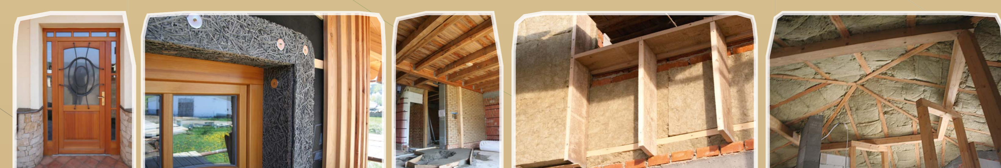
Uměleckořemeslné zpracování detailů stavby, používání dřeva na většinu konstrukcí staveb. Zateplení domu 240 - 300 mm silnou izolací. Art-craft realization of details of the building; wood is being used for most structures within the building. Overcladding using 240 - 300mm thick insulation material. Kunsthandwerkliche Gestaltung der baulichen Details, Verwendung von Holz für die meisten Baukonstruktionen. Wärmedämmung des Hauses mit 240 - 300 mm dicker Isolierung. Декоративная обработка деталей постройки, использование дерева в качестве материала большинства конструкций. Утепление дома изоляцией толщиной 240 - 300 мм.
