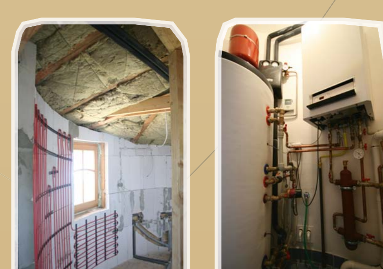
Nízkoteplotní stěnové vytápění a solární kolektory Low-temperature wall heating and solar collectors Niedertemperatur-Wandheizung und Sonnenkollektoren Низкотемпературное отопление в стенах и солнечные коллекторы
