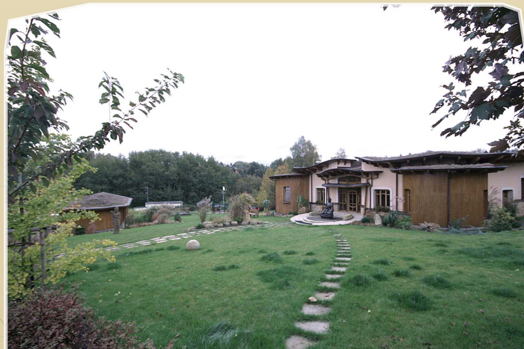
Citlivé umístění staveb do terénu Behutsame Einfügung der Bauten ins Gelände Деликатное вписывание строений в природную структуру
