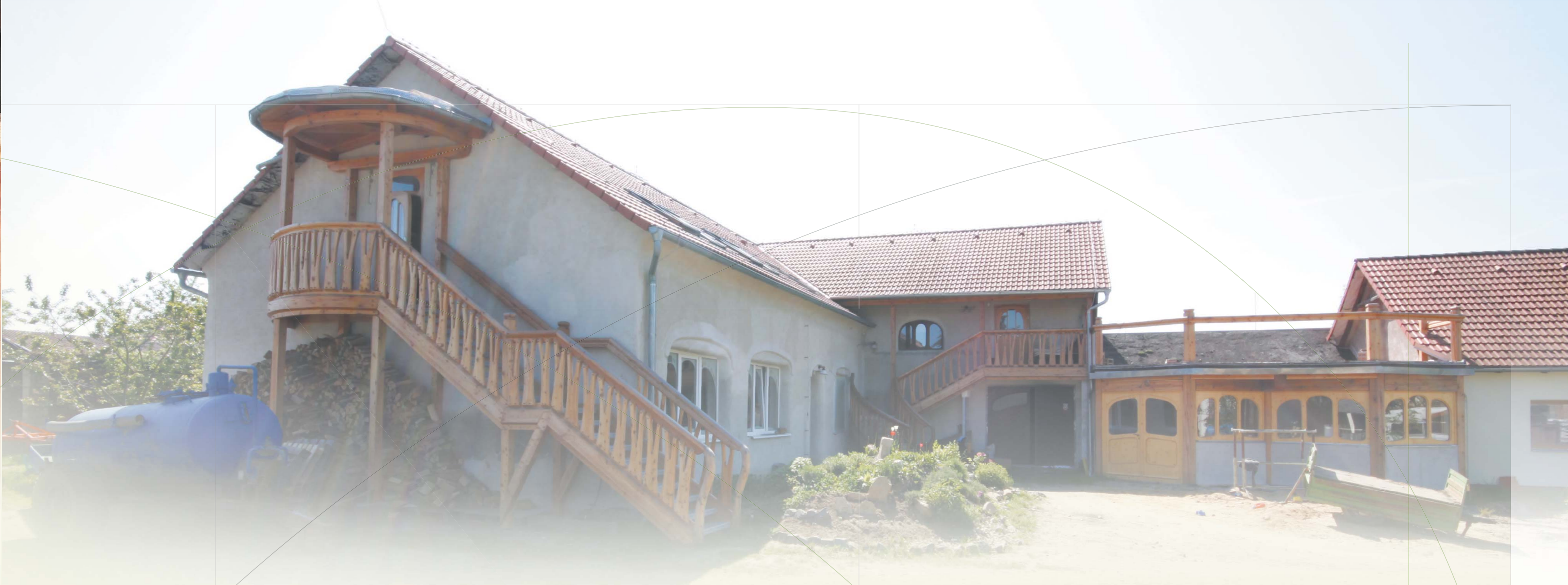
Sheltered workshops and housing Budovy chráněných dílen a ubytování Die Gebäude mit den Behindertenwerkstätten und mit Wohnung Здания закрытых мастерских для людей с ограниченными возможностями и жилье помещенцев
