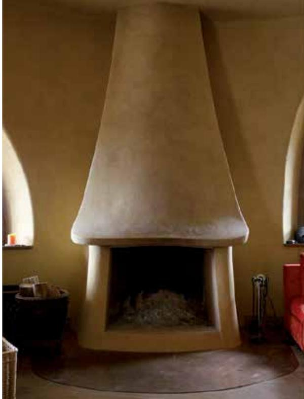
PUTZMEISTER. El revoco se mezcló en seco en una hormigonera. La mezcla consistió en arcilla, arenas de dos tamaños diferentes y fibra de paja de trigo de 1cm.
